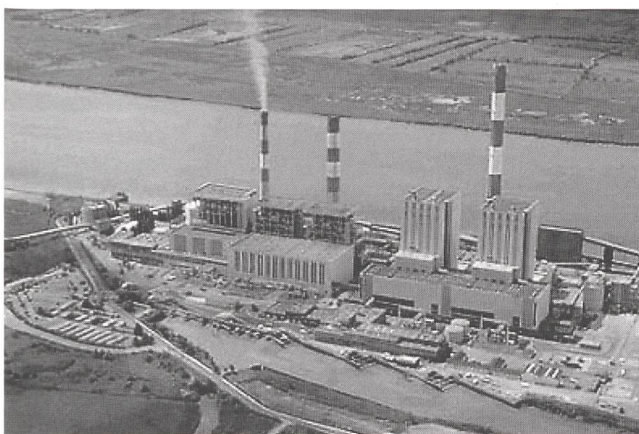
Thermisches Kraftwerk der EDF.
