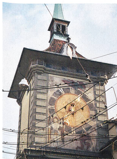
EMG-Abstimmung später (Stromleitungen vor Zytglogenturm in Bern).
