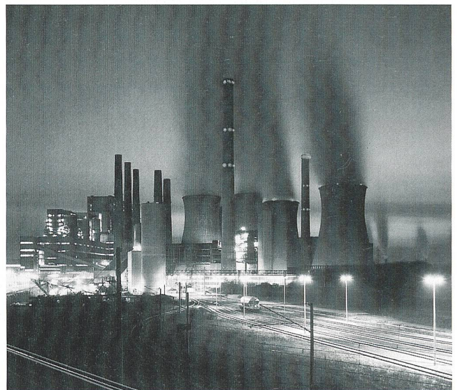
Grösstes Stromunternehmen im deutschen Markt ist die RWE AG (im Bild das Kohlekraftwerk Neurath).
