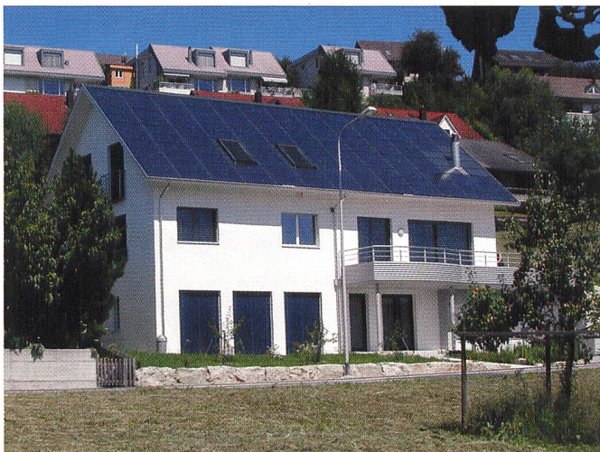
Bild 5 Das Einfamilienhaus der Familie Erni in Untersiggenthal AG. Die gelungene Integration wurde mit dem Solarpreis 2001 ausgezeichnet. Zur Anwendung kam das Solrif-Montagesystem (Bild Ernst Schweizer).
