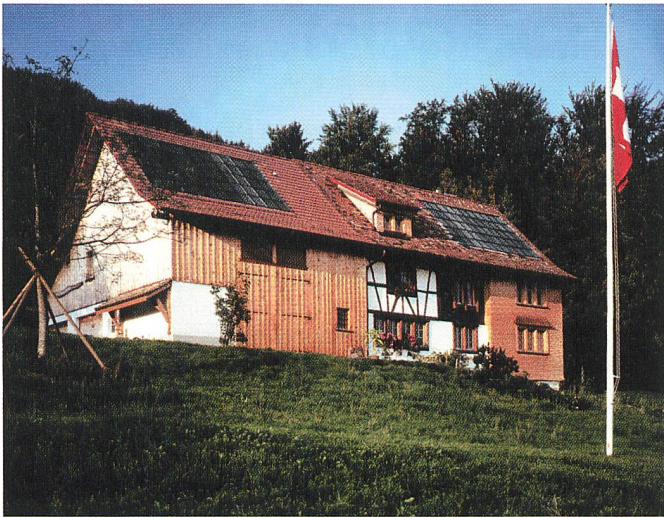
Bild 3 Der Solardachziegel Newtec wird heute in Deutschland produziert und kam auch schon verschiedentlich auf denkmalgeschützten Bauten zur Anwendung (Bild Phönix SonnenStrom AG).
