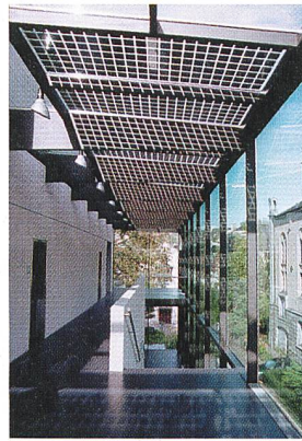
Bild 7 Licht- und Schattenspiel an der Kantonsschule Zürich-Stadelhofen: Hier sind Solarzellen direkt ins Glasdach der neuen Wandelhalle integriert (Bild Gian Vaitl).
