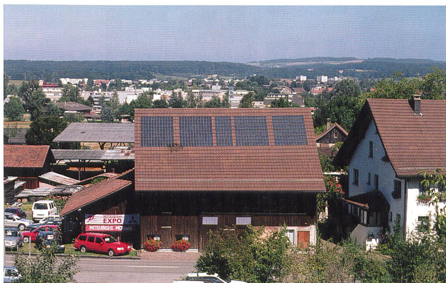
Bild 2 Mit dem «Sunny Tile» eingedeckt: Eine Scheune mitten im alten Dorfkern von Fällanden/ZH. Eine aufgesetzte Solarstromanlage hätte das Bauamt der Gemeinde hier nicht akzeptiert (Bild Andreas Rupp).
