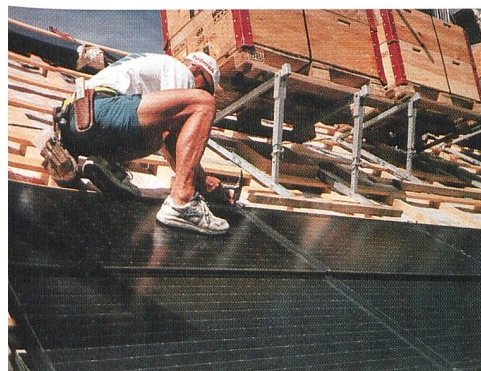
Bild 6 Dachdecker Rolf Nyffeler benötigt für die Montage der mit Solrif gerahmten Module nicht länger als für ein Ziegeldach (Bild Robert Kröni, Enecolo AG).
