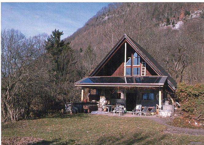
Bild 4 Abgestimmt auf Eternit-Dachschiefer: das Dachelement Sunjoule, hier ins Vordach eines Einfamilienhauses in Mollis integriert (Bild Eternit).
