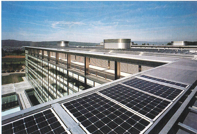
Bild 7 Die massgefertigten PV-Bauelemente sind horizontal angeordnet. Sie bilden die obere Abdeckung der Vordächer.
