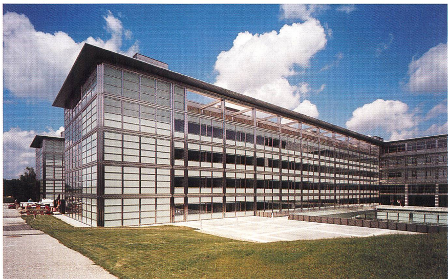
Bild 6 Die Vordächer mit den integrierten Solargeneratoren folgen der gesamten Gebäudekontur.
