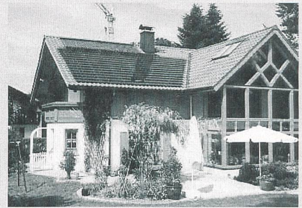
Photovoltaik-Boom auf deutschen Dächern (Bild SES 21).
