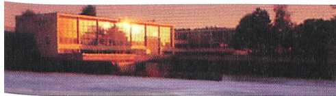
WKW Aarberg, das grösste Wasserkraftwerk mit dem europaweit strengsten Ökostromlabel naturemade star.
