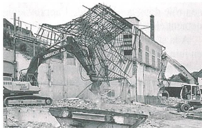
Abbruch des ehemaligen Gaswerkareals im Juli 2002 (Bild: Regionalwerke).
