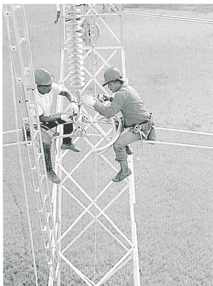
Verstärkung der grenzüberschreitenden Stromleitungen dringlich (Bild Alstom).
