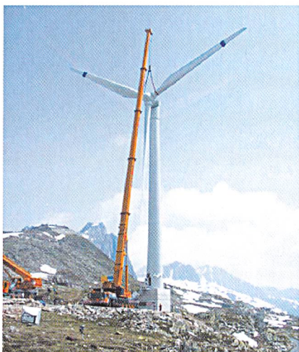
Bau der Anlage am Gütsch (UR).
