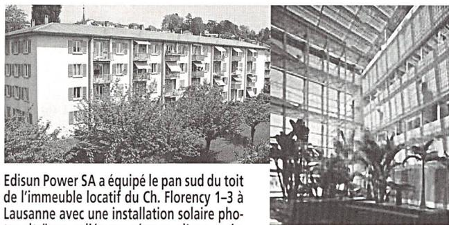
Edison Power SA a équipé le pan sud du toit de l'immeuble locatif du Ch. Florency 1-3 à Lausanne avec une installation solaire photovoltaïque reliée au réseau, d'une puissance nominale de 38 kW et d'une surface de 300 m<sup>2</sup>.
