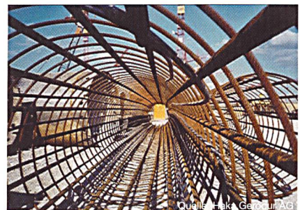
Bild 7 Energiepfahl für Unique Zurich Airport
