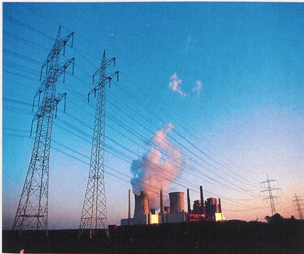
Deutschland: «Anlagen zur Stromerzeugung veraltet» (Bild BMU/Oed).
