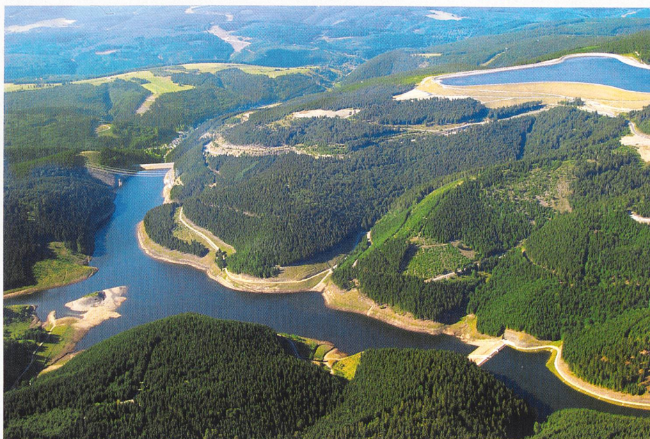
Pumpspeicheranlage Goldisthal (Bild Vattenfall).
