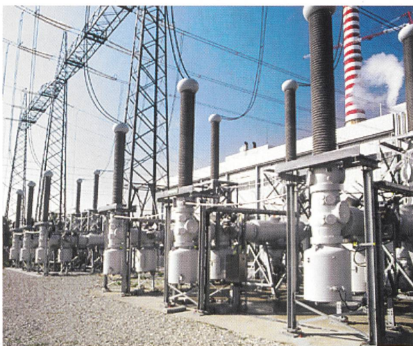
Hochintegrierte Schaltanlage.
