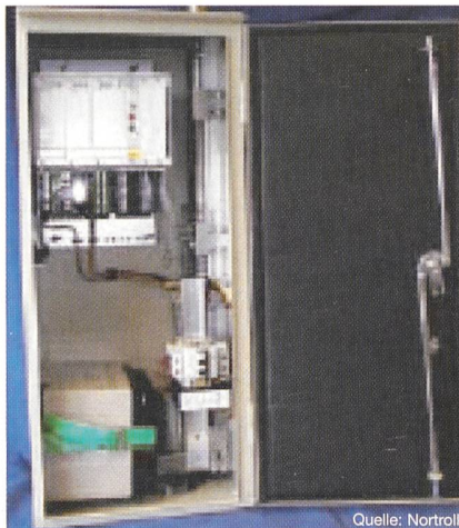
Bild 6 Nachrüstbarer Motorantrieb für Freileitungsstreckentrenner
