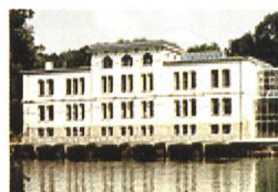
Kraftwerk Felsenau (Installierte Leistung: 11 500 kW/Jahresproduk- tion: 70 000 MWh).
