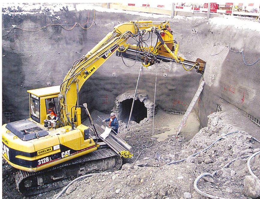
Baugrube «Entsanderbecken»: Erstellen der Nagelwand am Ende des künftigen Entsanderbeckens (Stolleneinlauf).
