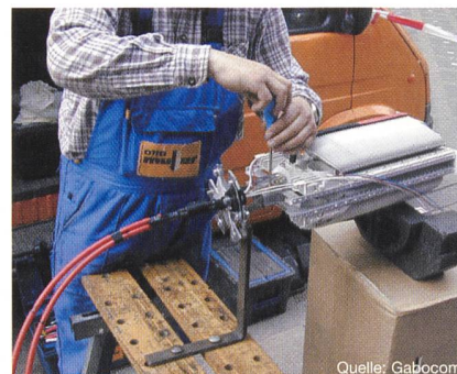
Bild 3 Spleissen der Kabel
