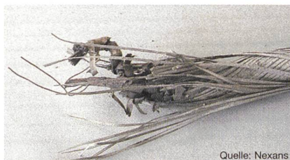
Bild 3 Teil der gerissenen Stelle
