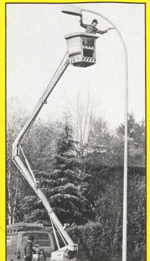
Korrosionsschutz an Stahlkandelabern
