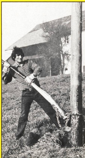
Nachimprägnierung von Holzmasten
