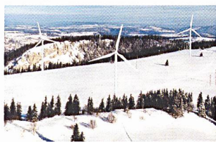
Bereits erfolgreich im Betrieb: Windkraftanlage im Jura.
