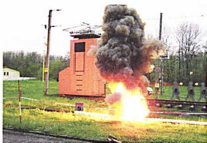
Demonstration einer Kabelverletzung (Bilder: cef).
