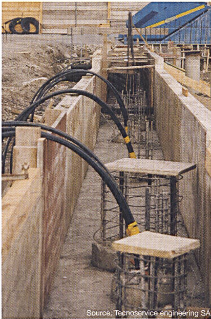
Figure 8 Système de pieux énergétiques pour le chauffage et le rafraîchissement d'un bâtiment Minergie: le Centre scolaire de Fully, Valais
