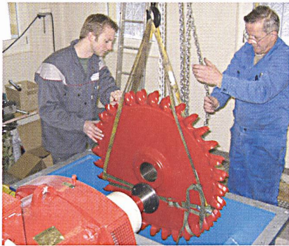
Montage de la roue Pelton dans la centrale hydraulique sur le réseau d'eau potable de Sachseln
