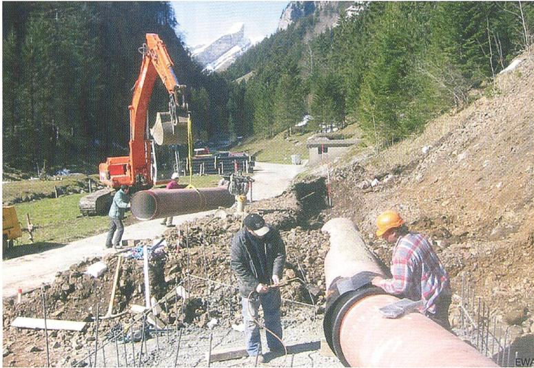
Bild 2 Teuerstes Projektelement: die neue Druckleitung
