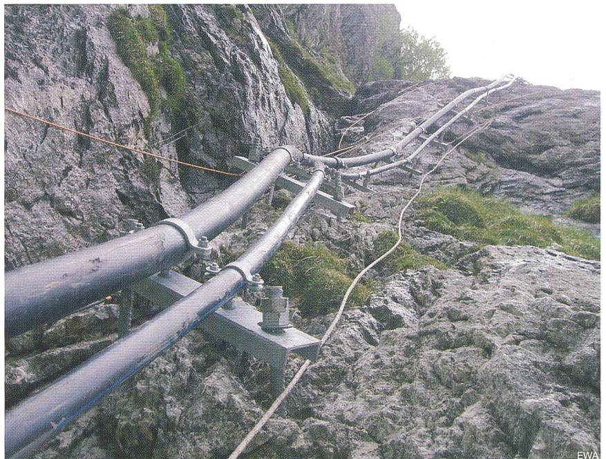
Bild 3 Verlegte Rohrleitungen in der Felswand vor der Meglisalp
