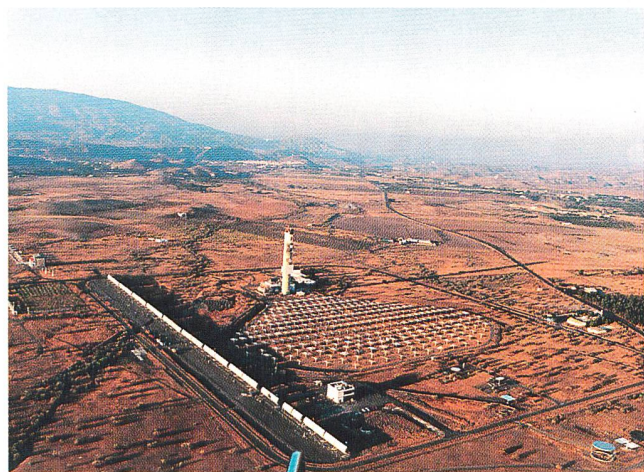
Energiezukunft mit solarthermischen Kraftwerken? Das Bild zeigt eine Luftansicht des Heliostatenfeldes der Plataforma Solar de Almería im Süden Spaniens. Es besteht aus insgesamt 300 Heliostaten mit je 39,6 m 2 Fläche. Das Heliostatenfeld dient dem «Einsammeln» der von der Sonne kommenden Strahlung. Es besteht aus einer grossen Zahl so genannter Heliostate. Dabei handelt es sich um grosse, leicht gekrümmte Spiegel, die zweiachsig der Sonne nachgeführt werden können. Die Strahlung wird ähnlich wie bei einem Brennglas in einen Brennpunkt konzentriert, der sich auf der Spitze eines Turmes befindet. Der Konzentrationsfaktor ist dabei etwa 500- bis 1000fach (Bild: DLR-Institut für Technische Thermodynamik).
