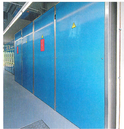
Die zwei Doppelzellen der Rectiphase-Kompensationsanlage.
