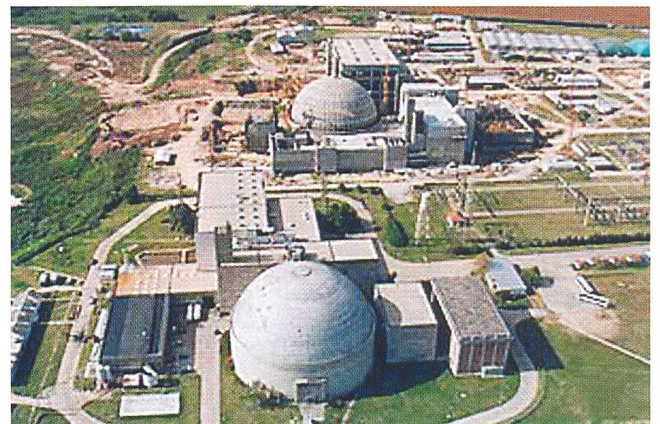
KKW Atucha soll fertiggestellt werden (Bild IAEA).
