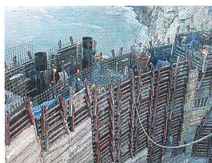
HydroOGK-Wasserkraftwerk Gunib in Bau.
