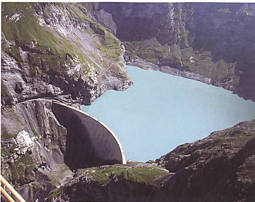
Staumauer Linth-Limmern (Bild: axpo).
