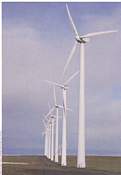
Condon Wind Farm in Condon, Oregon, USA: 43 Turbinen des Typs Mitsubishi MWT600 liefern eine Leistung von 49,8 MW.
