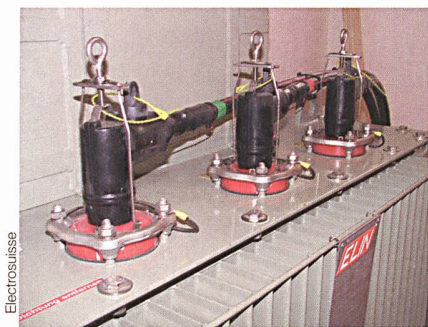
Figure 7 Circuit primaire du transformateur.
