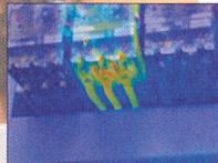
Wärme- und Sichtbild überblendet
