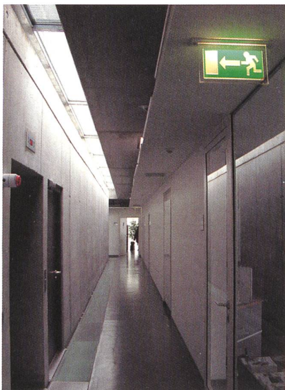
Bild 2 Tageslichtnutzung von oben nach unten durch Glasflächen im Boden der Gänge.
