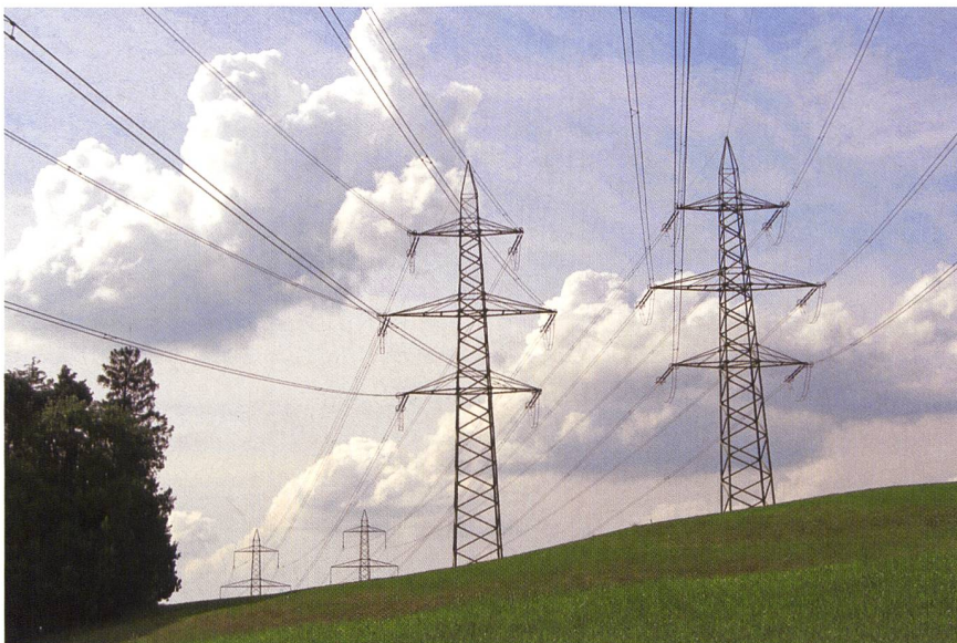
Bild 1 Durchhang von Hochspannungsleitungen.
