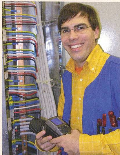
Oben: Martin Kenner, zuständig für Netzanalysen, beim Messen der Anlaufströme der Axialventilatoren. Unten: Urs Walti, zuständig für EMV- und Netzanalysen sowie für Thermografie, beim Thermografieren einer Schaltgerätekombination.
