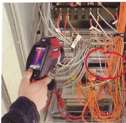
Übersicht im thermischen Bereich: Wärmebildkamera Flir i50 von Emitec.
