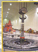
Kraftwerk-Retrofit und Neubau
