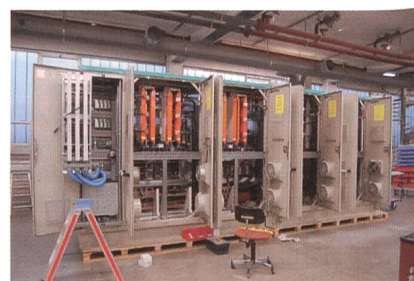
Schaltschrankmontage bei der Firma Simatex.
