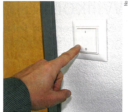
Die eingesetzten Stand-by-Stromschalter (Funkbussystem Ratio) sind batterieless.
