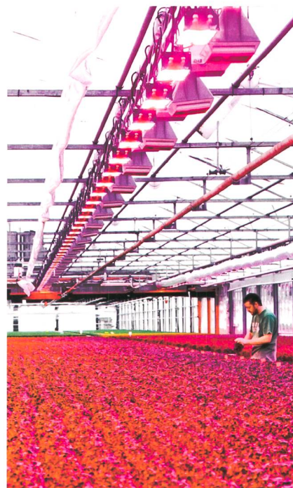
In einem Pilotprojekt in Dänemark beleuchteten etwa 50 000 LED eine Anbaufläche von mehreren 1000 m 2 . Der Stromverbrauch in dem Gewächshaus sank um 40%.
