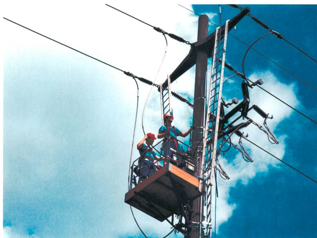
Arbeiten an einer Übertragungsleitung: Überarbeitete Vorschriften sind zu beachten.
