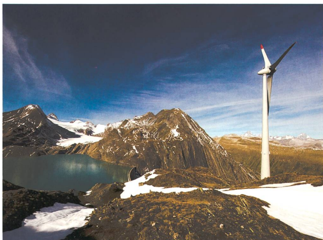
Ab Anfang 2012 geht die Windenergieanlage am Gries im Wallis ans Netz. Die Investitions- kosten betragen 5,5 Mio. CHF.
