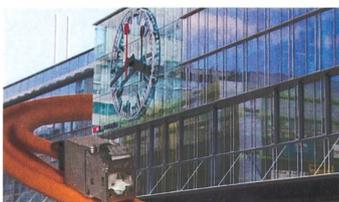
Parallel eingezogene «Mini-Tubes» ermöglichen eine spätere Ergänzung mit Glasfaserkabeln.
