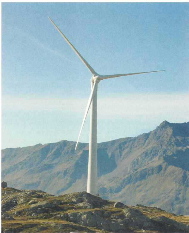
Ursprüngliche Lagervey-Windkraftanlage auf dem Gütsch.
