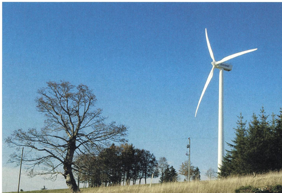
Les progrès techniques confèrent aujourd'hui fiabilité et performance aux énergies renouvelables.
