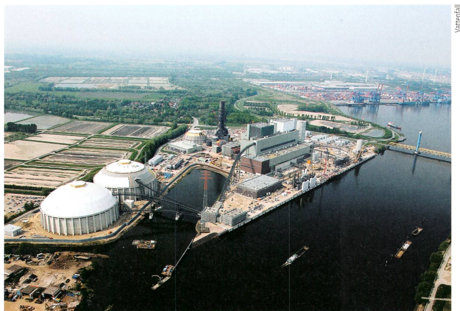
Bild 3 Das Grosskraftwerksprojekt Hamburg-Moorburg von Vattenfall ist ein Beispiel dafür, wie wechselnde politische Rahmenbedingungen den Takt angeben: Seit 1999 in Planung, wartet es bis heute auf die vollständige Inbetriebnahme.
