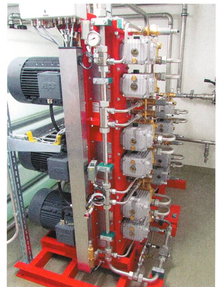
Motoreinheit, die den Hochdruck von 140 bar für den Wasserebel erzeugt.
