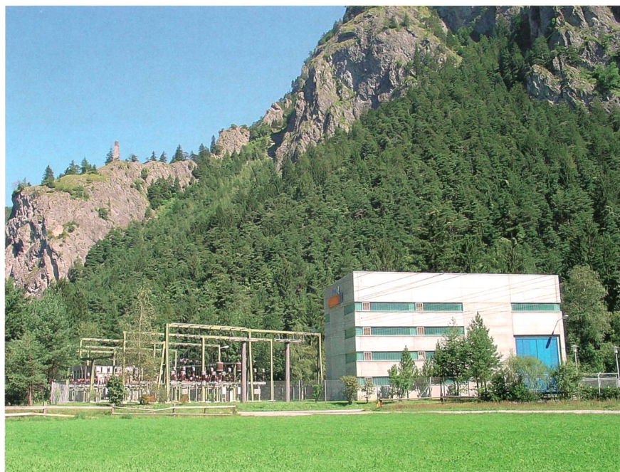
Bild 1 Die Kraftwerkszentrale Rothenbrunnen.
